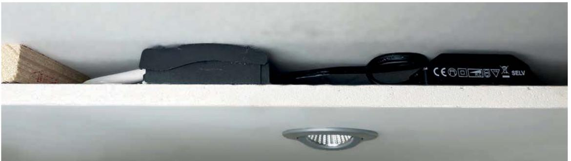
6 - Das Ergebnis: eine kompakte Installation mit einem schwenkbaren Spot, einem dimmbaren Netzgerät sowie der Möglichkeit zur Durchgangsverdrahtung im Deckenhohlraum – ideal im Sanierungsbereich.
