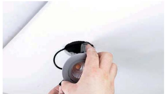
5 - Einsetzen des Spots in den Deckenausschnitt
