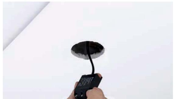
3 - Kompaktes Netzgerät wird in den Hohlraum eingeschoben
