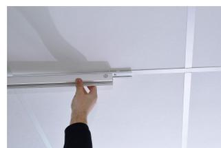
Mittels dieses kleinen »Tausendsassas« wird die Montage einer Stromschiene an einer vorhandenen Rasterdecke zum Kinderspiel. Die Montagezeit beträgt nur noch ein Bruchteil von der bisherigen. Die Klammer wird im ersten Schritt ganz einfach in die sichtbaren Metallstreifen der Rasterdecke ein-geklickt und hält mittels Sicherheits-Federbügel bombenfest an der Decke. Danach wird einfach nur noch die Stromschiene drauf geschoben und fertig ist Montage.
